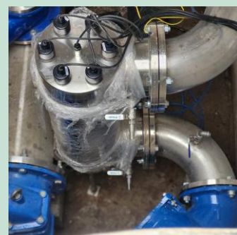
Modernizacja w ujęciu wody MZWiK
