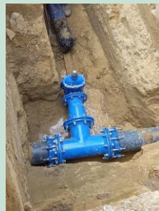
Wymiana rur azbestowych sieci wodociągowej w Wąwolnicy
